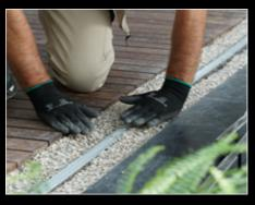
Pour des applications à l'extérieur, prévoir au moins 300 mm de gravier de drainage supplémentaires à sous l'appareil ou un système de drainage approprié.
